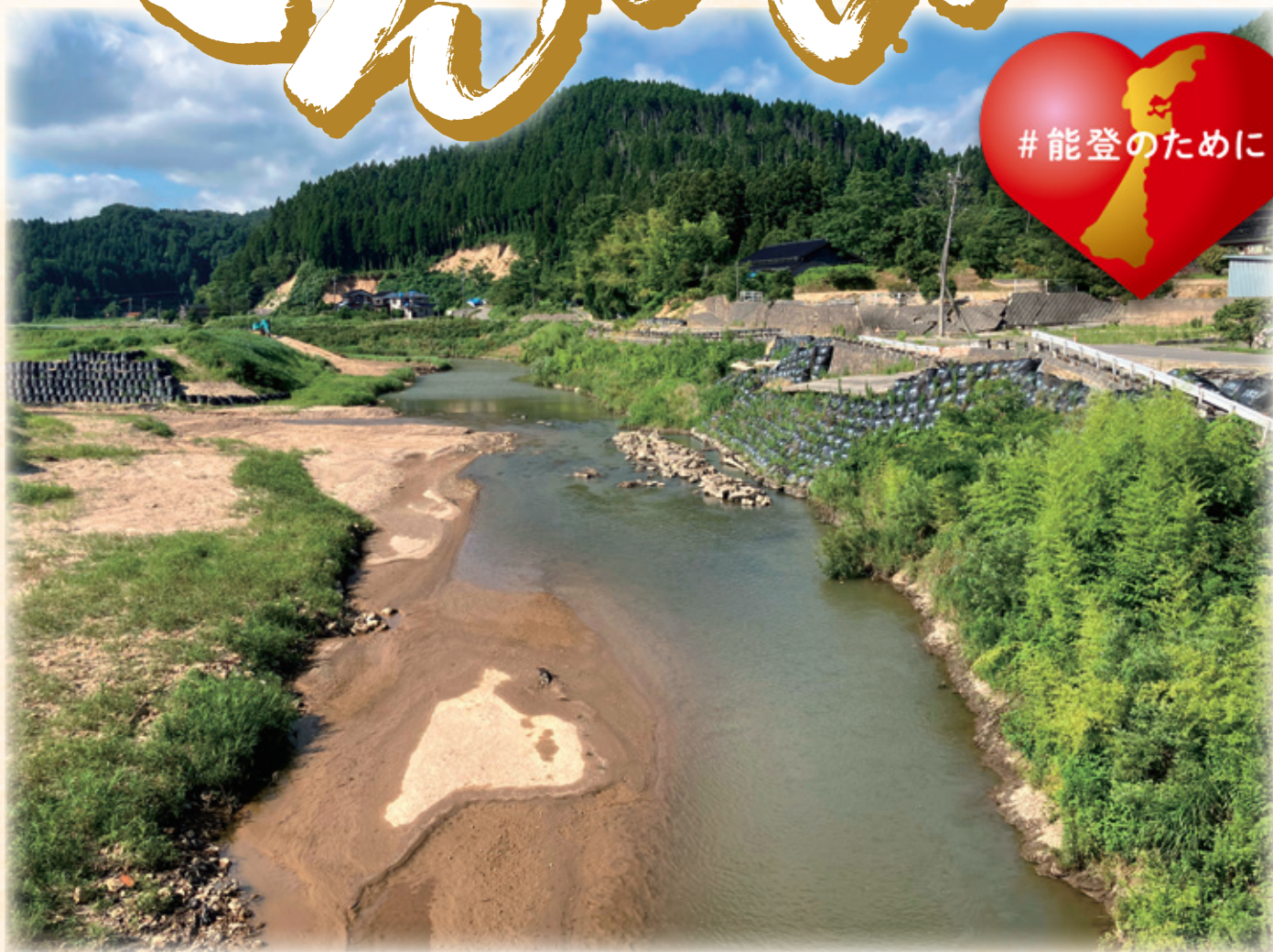
震災と豪雨の被害から応急復旧工事を行っている町野川の今の様子
