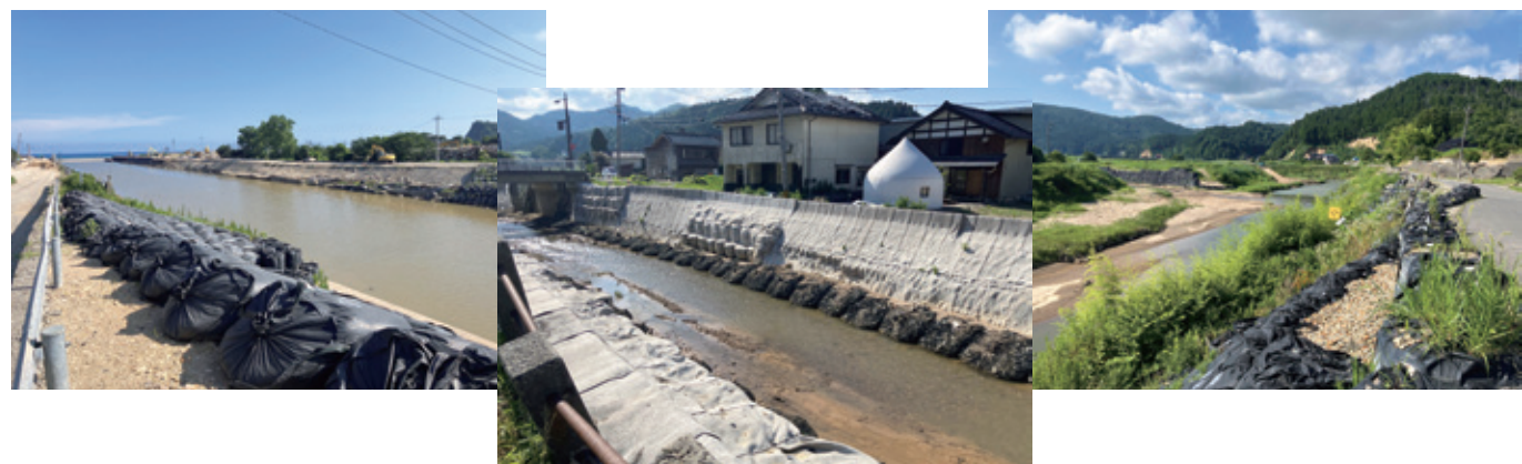
左岸、右岸とも多くの土嚢を積み上げ応急復旧を行っている河川の様子
