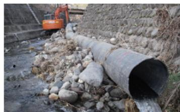
仮設パイプで作業場所の水を切り回そうとしている
