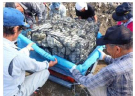
⑧モジ網を巻き終わったら、塩ビパイプに開けたスリットに格納する。
