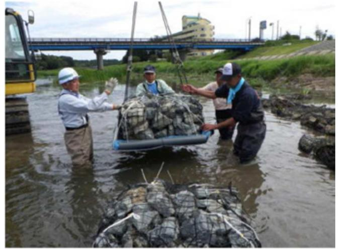
⑬重機で吊り上げて河川に設置する。設置は河床の状況や水深を確認しながら行う。河床に凹凸がある場合は重機で均す。
