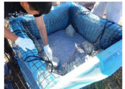
②洗掘防止マットの上に型枠を乗せ、モニタリングで使用するモジ網を型枠に入れる。そこへクッションマットを敷いた石倉カゴを置く。
