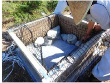
⑩モニタリング用の3基以外は、洗掘防止マットの上に型枠を乗せ、モジ網は入れずにクッションマットを敷いた石倉カゴを入れる。
