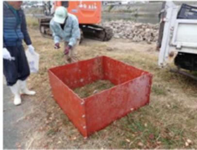
①型枠を組み立てる（写真型枠は鉄製）。
