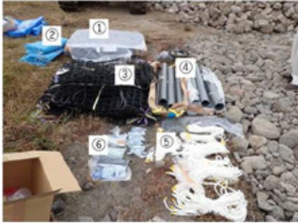
石倉カゴ増殖礁一式（①洗掘防止マット及びクッションマット、②モジ網（生け簀網）、③石倉カゴ、④モジ網を格納する塩ビパイプ、⑤孕み防止用などロープ式、⑥結束バンド）
